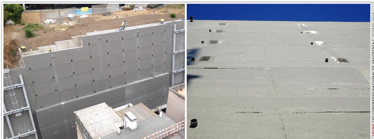
Figura 14 – Vistas dos muros de suporte após intervenção - Solução A
